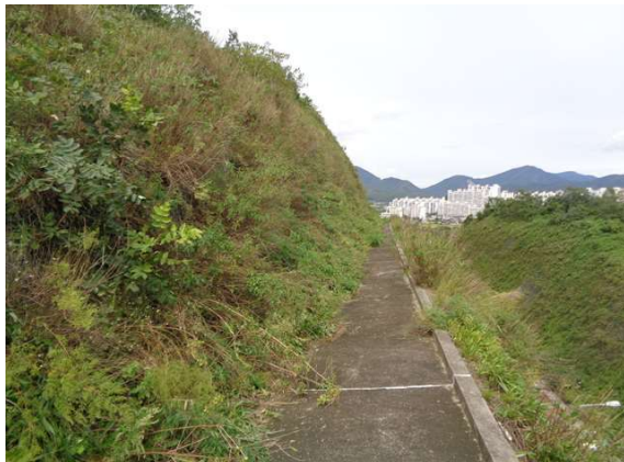
1소단 배수로 전경
