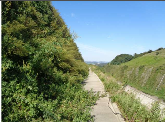
1소단 배수로 전경
