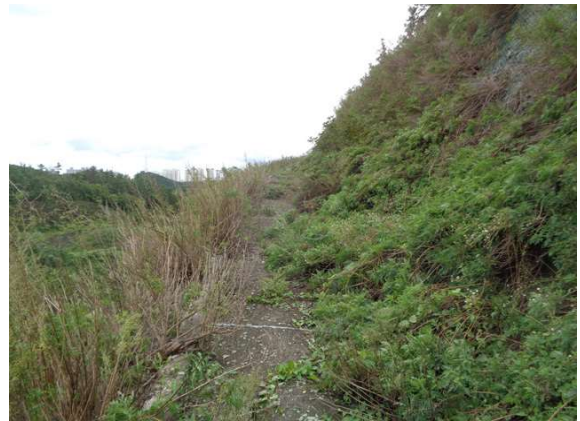
2소단 배수로 전경
