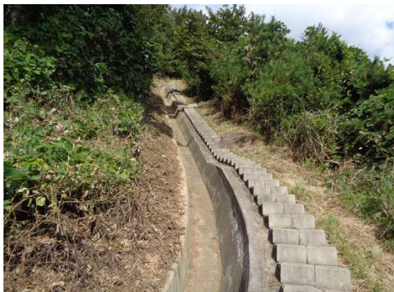
산마루측구, 점검계단 전경
