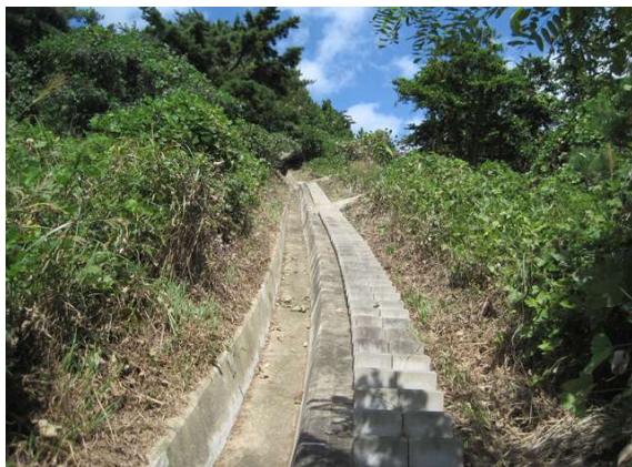
산마루측구, 점점계단 전경
