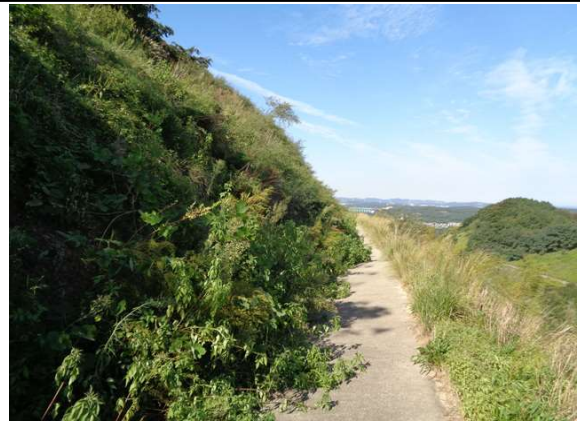
2소단 배수로 전경
