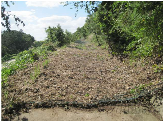
1소단 배수로 전경
