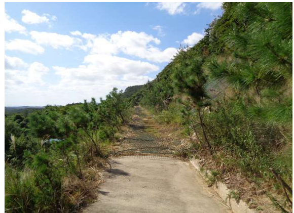
2소단 배수로 전경
