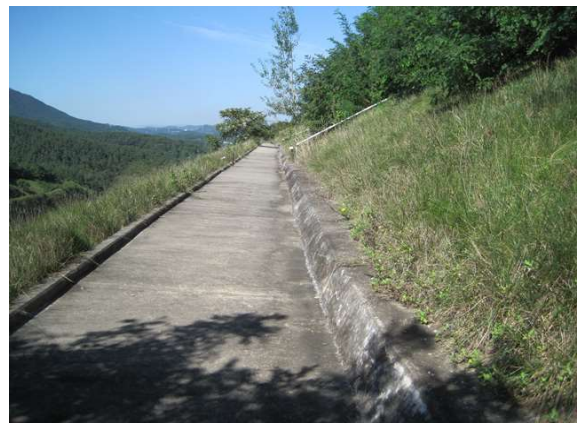
2소단 배수로 전경
