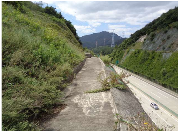
1소단 배수로 전경
