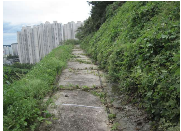
2소단 배수로 전경
