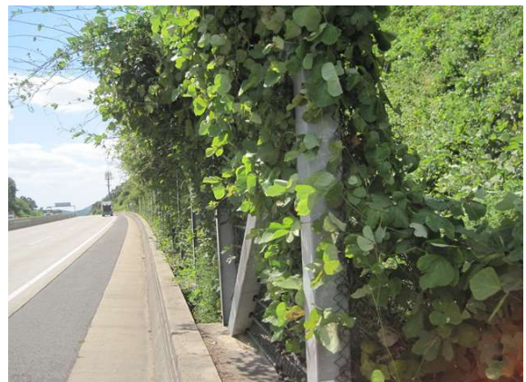
하부, 낙석방지울타리 전경
