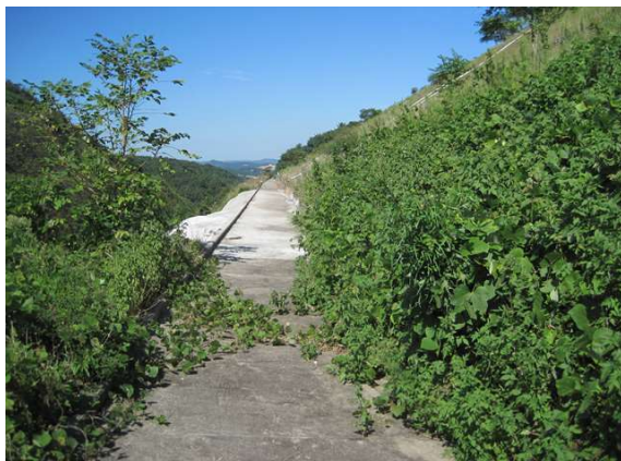
1소단 배수로 전경
