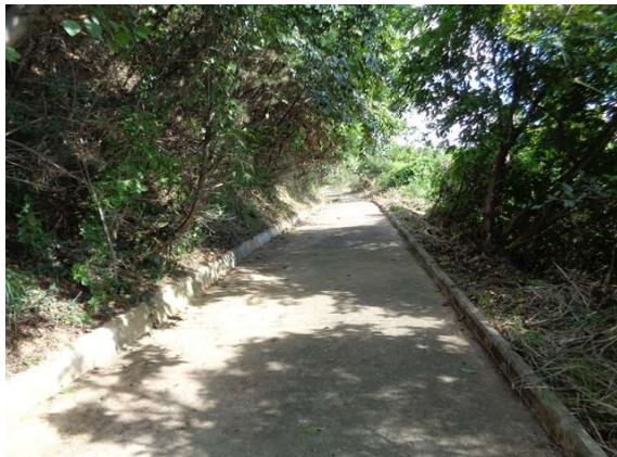
1소단 배수로 전경
