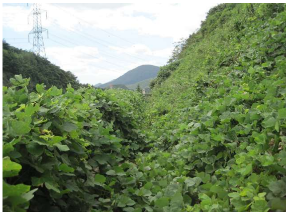
1소단 배수로 전경
