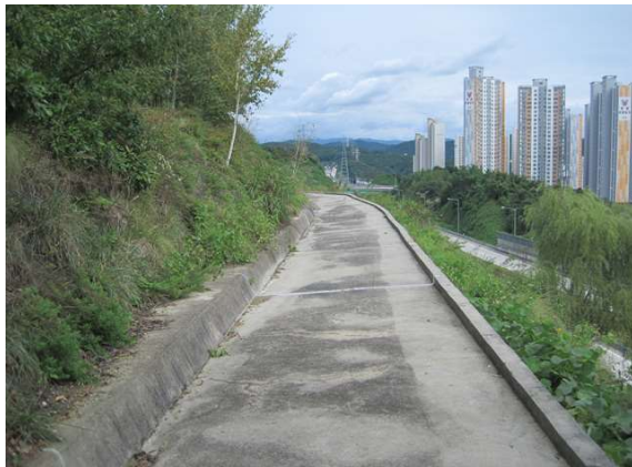
1소단 배수로 전경
